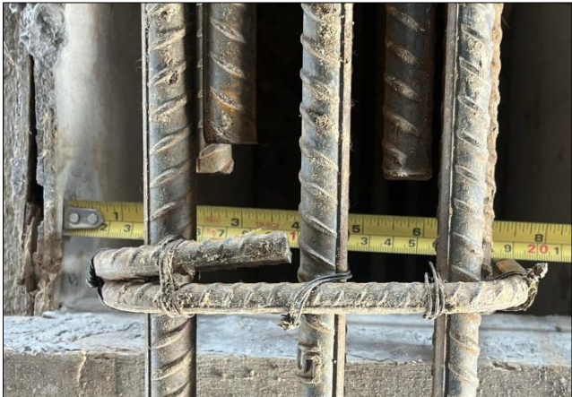
Gambar 3.1 Kondisi Panjang Tumpuan Metal Deck Aktual (±25 mm)
