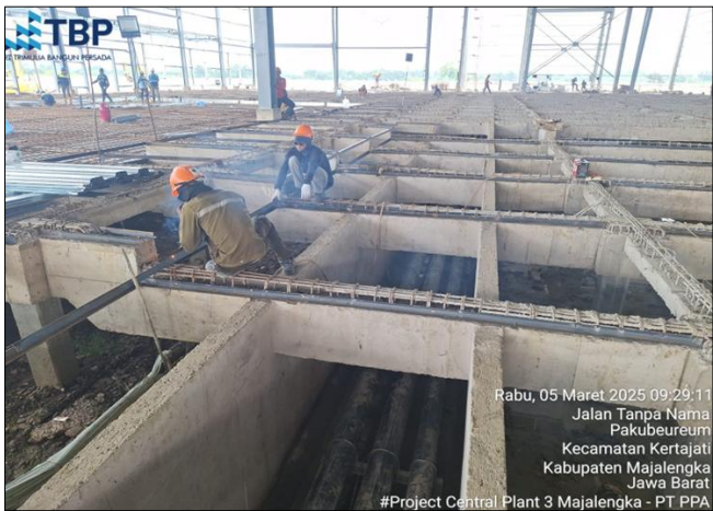
Gambar 3.2 Pengelasan Angle Bar pada Senggang Balok sebagai Tumpuan Metal Deck
