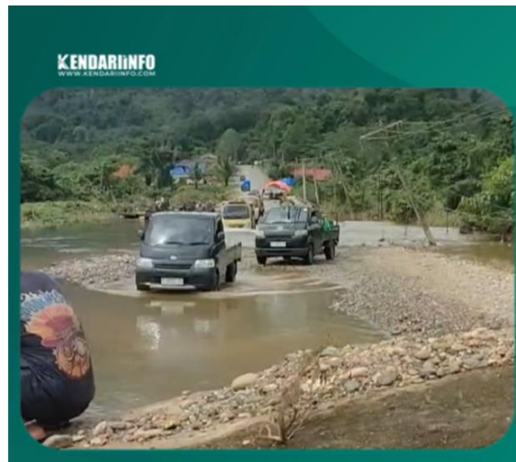
Gambar 7. Kondisi jalan Trans Sulawesi pascabanjir dengan genangan yang merusak badan jalan.
